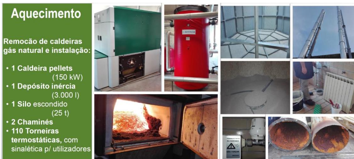
Figura 5 – Solução implementada: Caldeira a biomassa e equipamentos complementares
