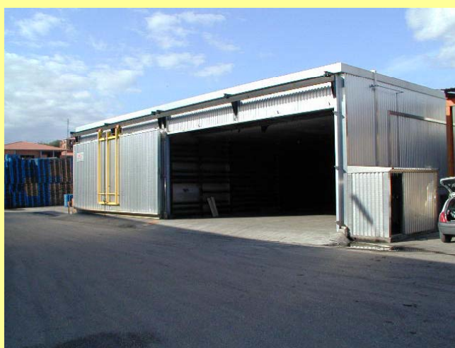
► Câmara de Tratamento, MAFREL, Tomar.
