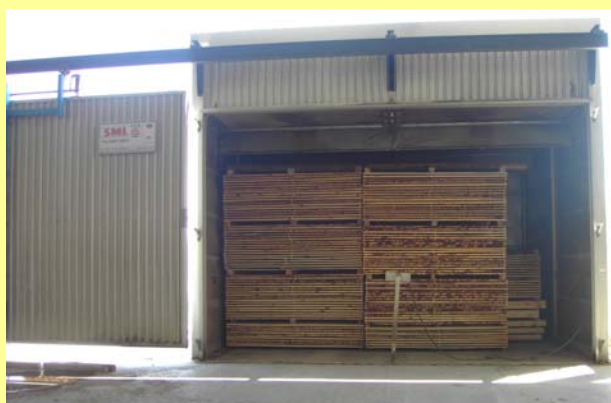
► Câmara de tratamento (secador). Tem uma capacidade de tratar 35-40 m 3 de madeira serrada ou cerca de 1000 paletes montadas. Madeiras do Vale da Calvina, S.A., Caranguejeira.
