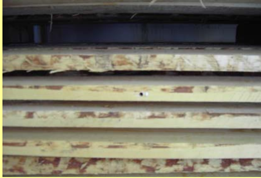
► Abertura do orifício para a colocação da sonda. Madeiras do Vale da Catarina, S.A., Carangajêta.
