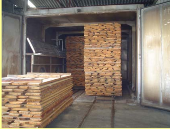
► Carregamento do secador com madeira para tratar
